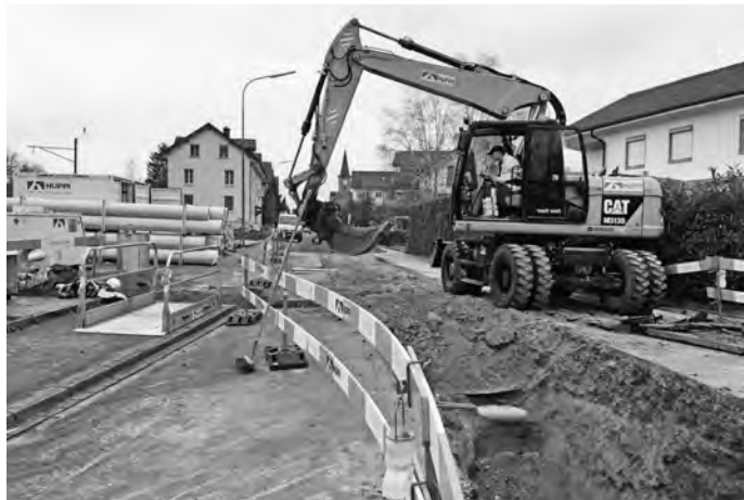
Arbeiten im Baustellenbereich.
